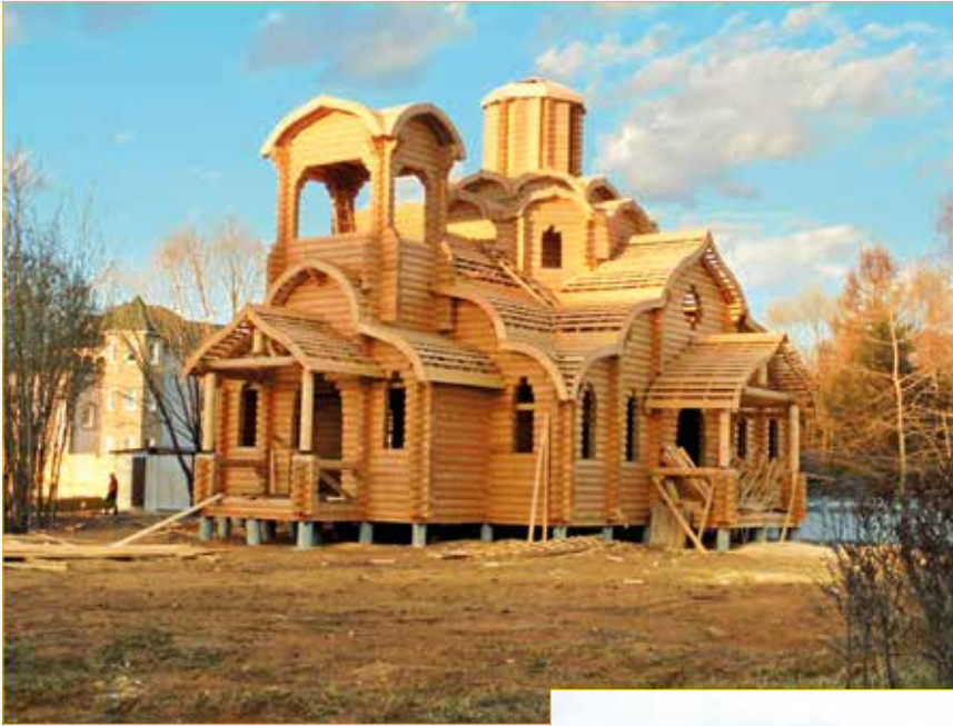
Храм равноапостольной Марии Магдалины в Южном Бүтөвө подготовлен к покрытию кровлей
