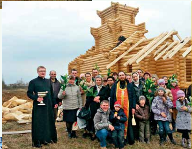
Храм во имя Преподобного Моисея Муриня в Южном Бүтөвө. Устанавливается стропильная система кровли, ведется укрепление фундамента
