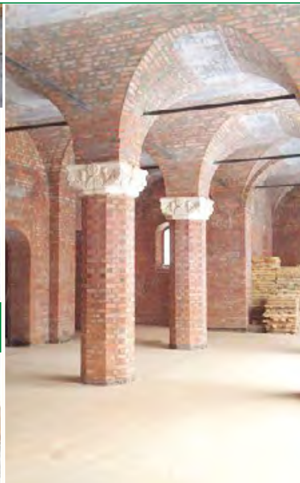
Храм Калужской иконы Божией Матери Демонтаж опалубки центральной части сводов нижнего яруса
