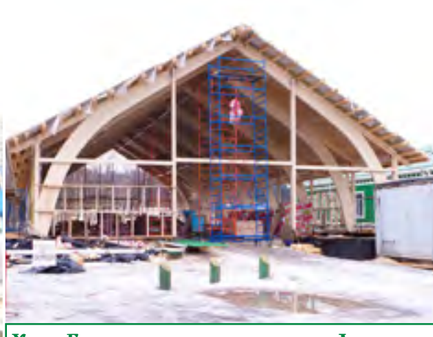
Храм Благоверного великого князя Димитрия Донского в Северном Бүтөвө. Строительство спортивно-оздоровительного комплекса
