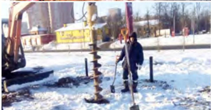
Храм Преподобного Моисея Мурина в Южном Бүтөвө. Монтаж свайного фундамента
