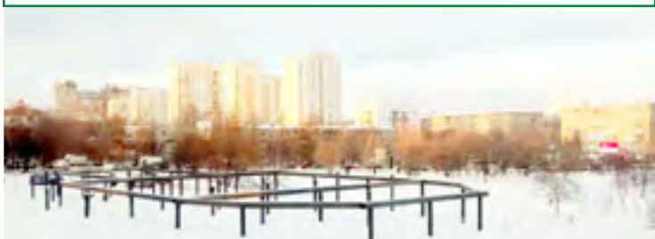
Храм Святой равноапостольной Нины, просветительницы Грузии, в Черемүшках. Свайное поле для временного храма
