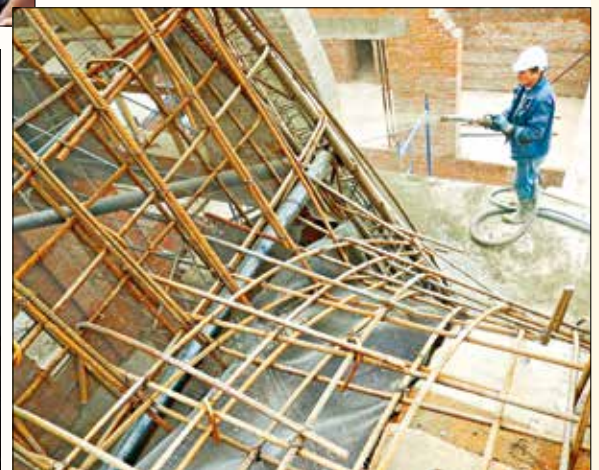
Храм Пророка Илии в Северном Бүтөвө. Монтаж сводов
